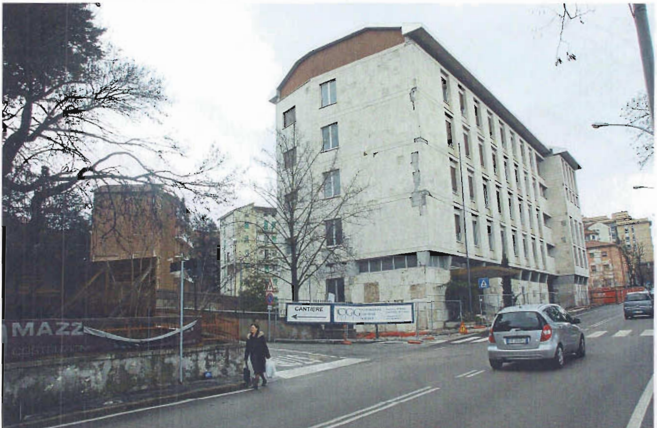
04 – il fronte nord-ovest dell'edificio Anas da Via XX Settembre
