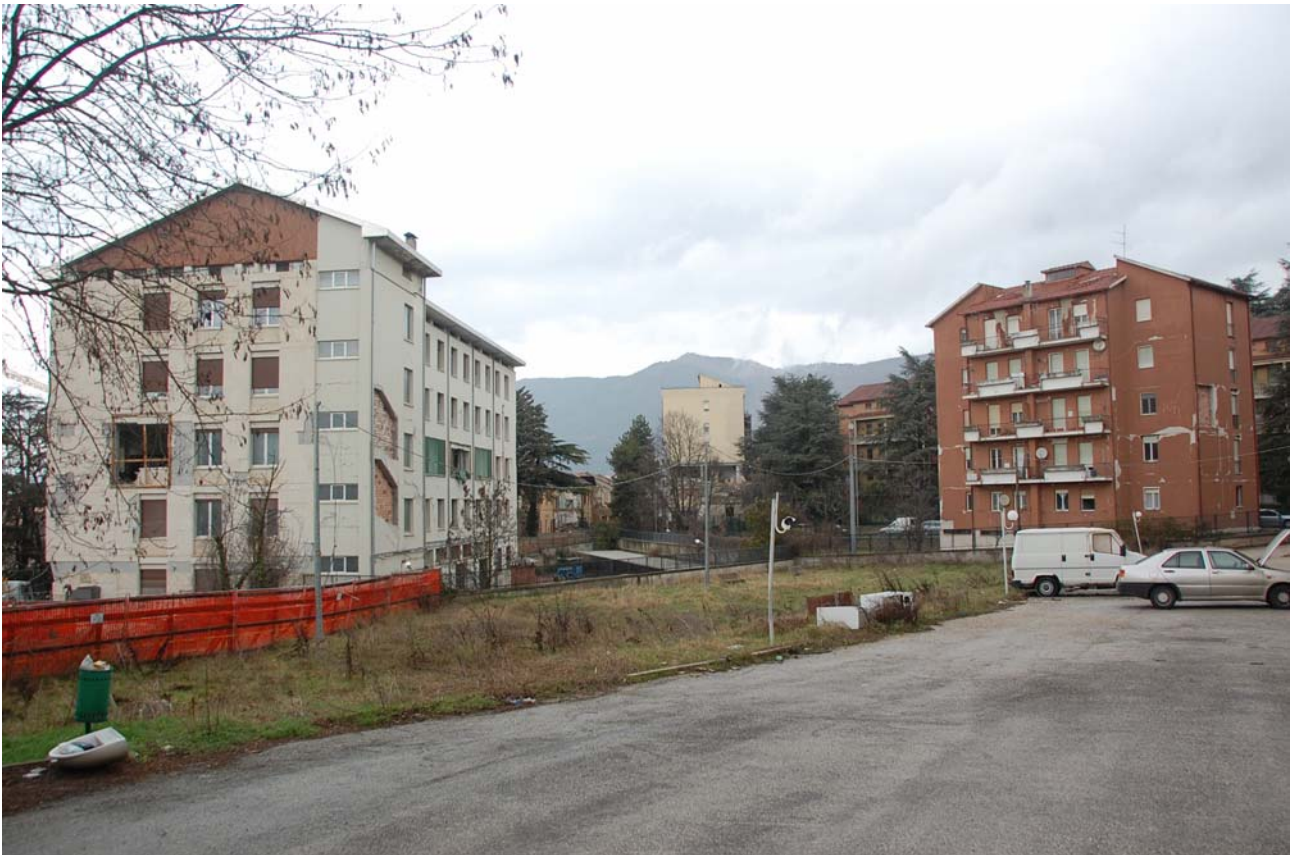
Vista interna all'area da sud – da sinistra l'area di sedime dell'edificio ATER crollato, l'edificio Anas e a destra il condominio di Via Castiglione
