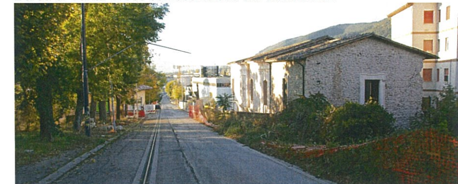
Vista da monte di Via Roma, con a destra Santa Croce
