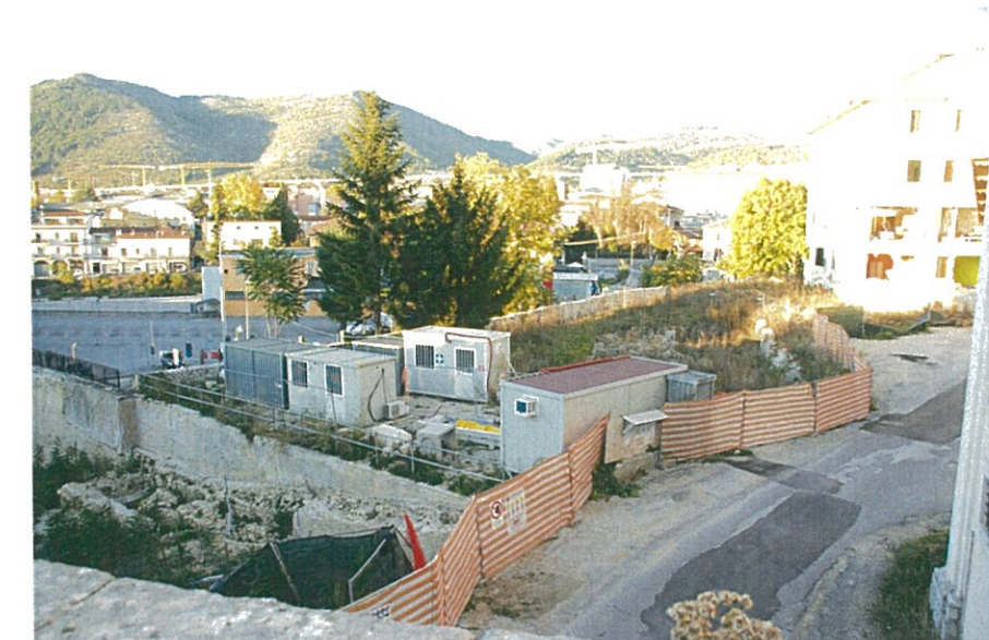
Viste esterne e interne dell'area
