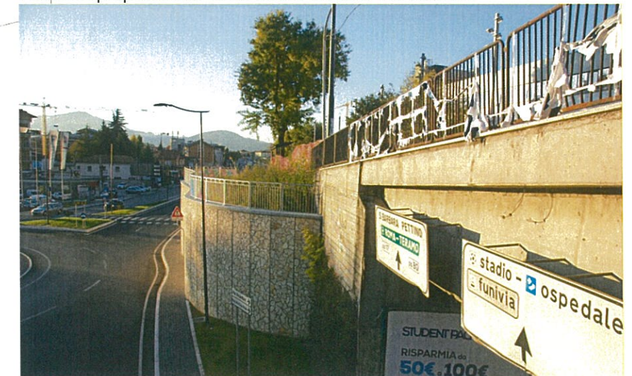
Il viadotto di Via Roma e le opere recentemente eseguite a confine con Viale Corrado IV
