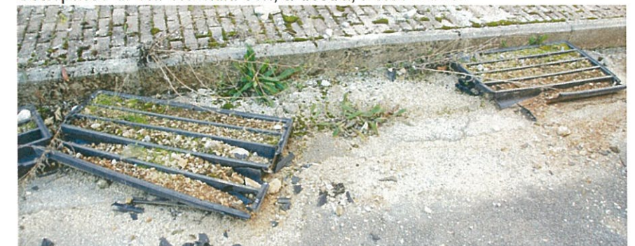
I sondaggi mostrano il terreno di riporto su cui si fonda l'area
