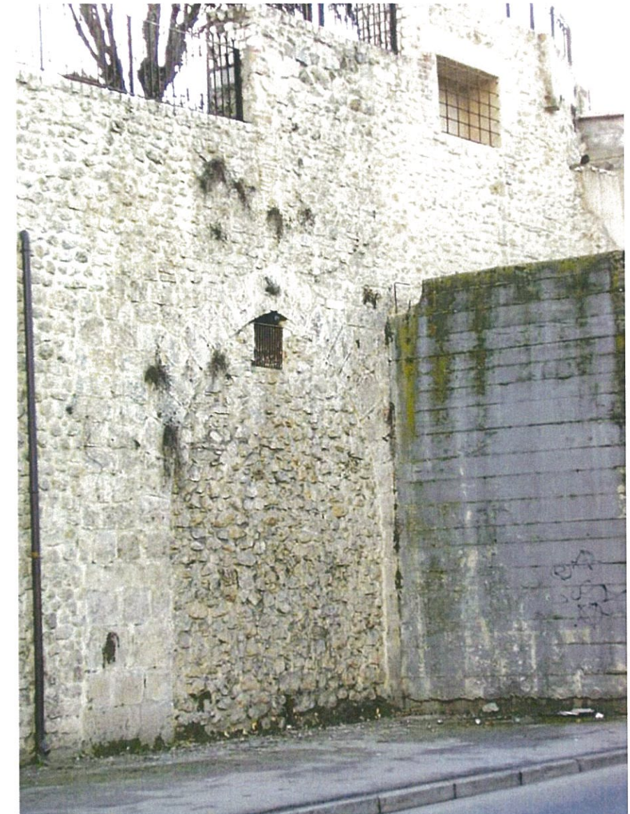
Porta Barete murata e parte delle strutture di spalla al sovrappasso di Via Roma su Via Vicentini
