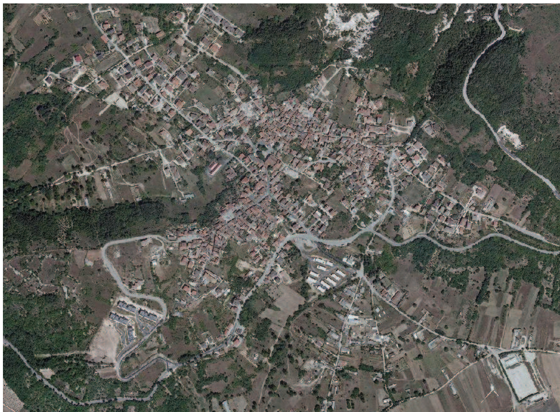
Figura I.4.36: Il centro storico di Arischia dopo il terremoto
