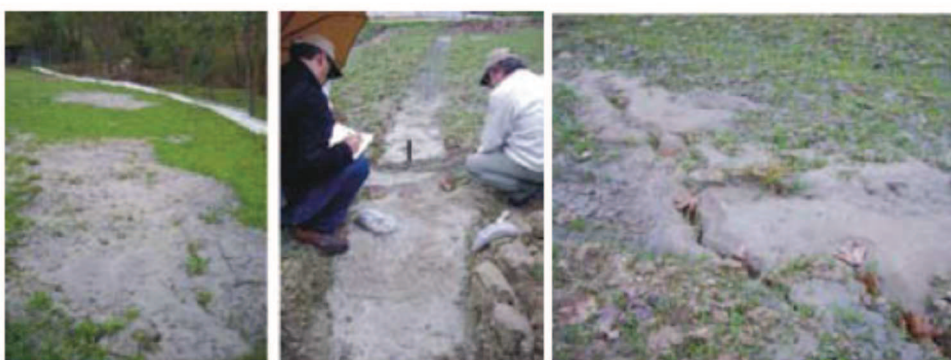
Figura II. 3.15 Fenomeni di liquefazione verificatisi in occasione del sisma del 6 Aprile 2009, rilevati tra di Via Ponte Rosarolo, S.S. 17 e la ferrovia (Tratto da MZS dell'area aquilana).
