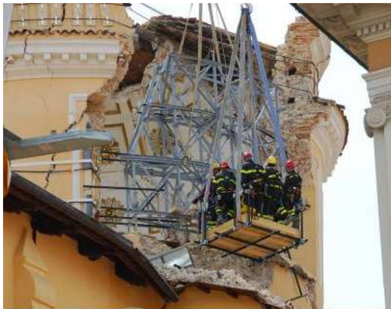
FASE 1: TRALICCI PER IL RIPRISTINO DELLE MURATURE CROLLATE
