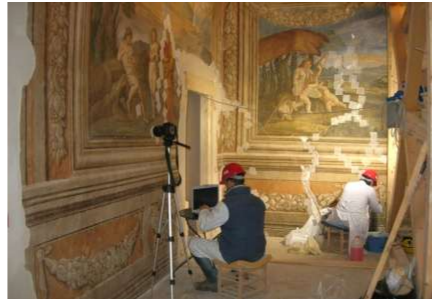
Messa in sicurezza in situ
