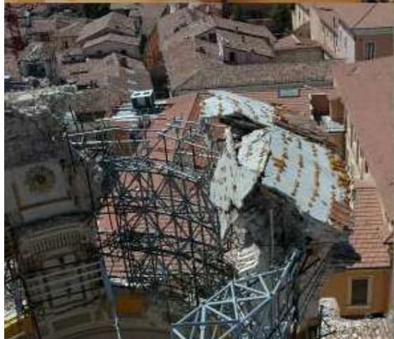
FASE 2: STRUTTURA A RAGNO PER IL PUNTELLAMENTO DELLA CUPOLA
