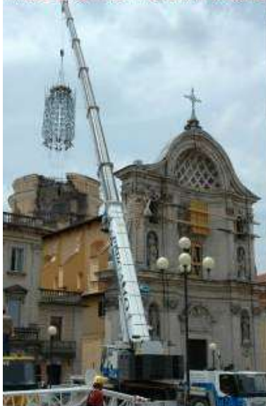
FASE 3: COPERTURA CUPOLA PER PROTEZIONE DAGLI AGENTI ATMOSFERICI
