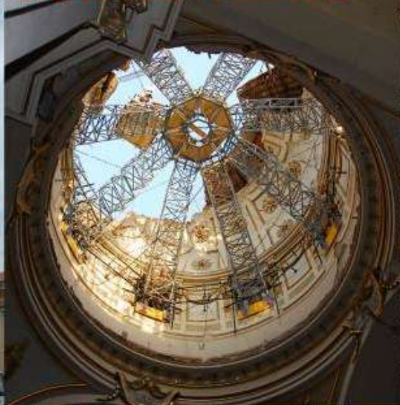
FASE 3: COPERTURA CUPOLA PER PROTEZIONE DAGLI AGENTI ATMOSFERICI
