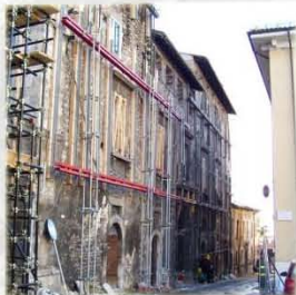
Vista del palazzo dalla Piazza
