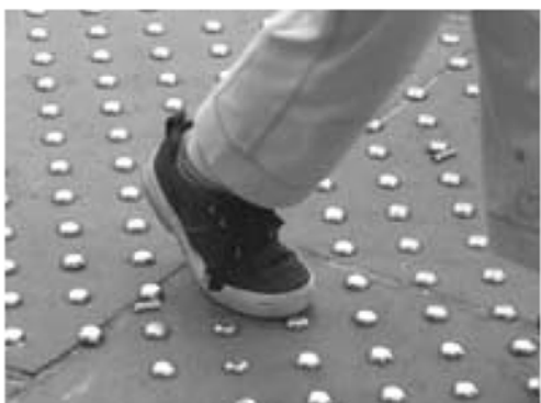
1) Le segnalazioni tattili di pericolo sono utili ai non vedenti e costituiscono al tempo stesso un segnale dissuasivo per tutti
