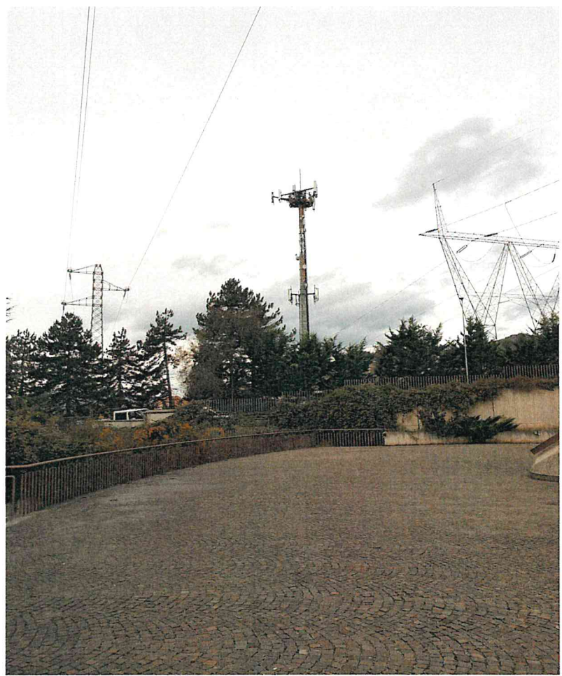
nell'immagine: a sinistra: elettrodotto da 150 KV al centro: SRB - gestori telefonia mobile TIM, WIND3, ILIAD a destra: elettrodotto da 220 KV il tutto rientra in un raggio di 85 metri dal lato Nord-Ovest dell'edificio scolastico
