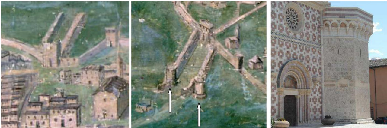
Due stralci della cinta difensiva della città dell'Aquila dalla carta di Egnazio Danti (1581): si evince l'uso di torri ottagonali ammassate ai recinti delle anti-porte e di porte con forma analoga a quella dell'ingresso principale della basilica, visto dall'interno. A destra, la torre ottagonale ammassata al lato sud della facciata.
